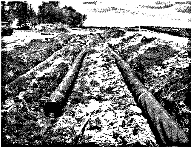
图 1-7 建设中的无砾石管式地下渗滤系统
