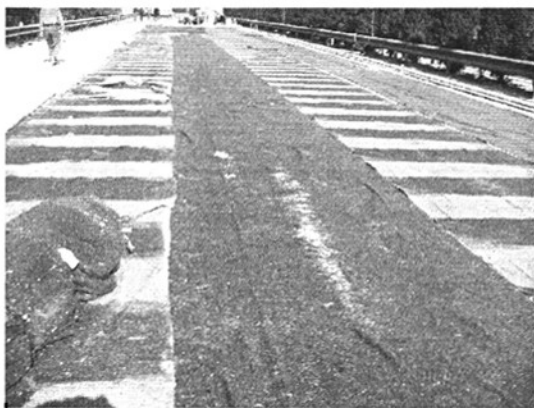
图3-2 再生集料混凝土基层养护图
