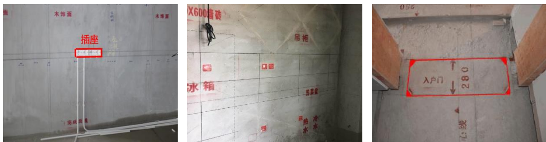
图 6-8：各种施工定位线示例
