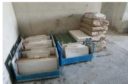
图 2：楼层现场堆放区
