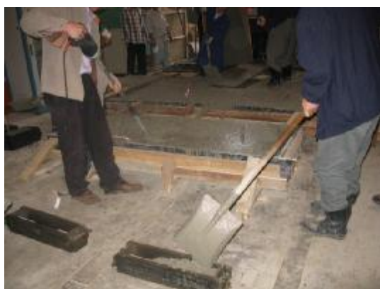
c. 混凝土浇注和振捣
