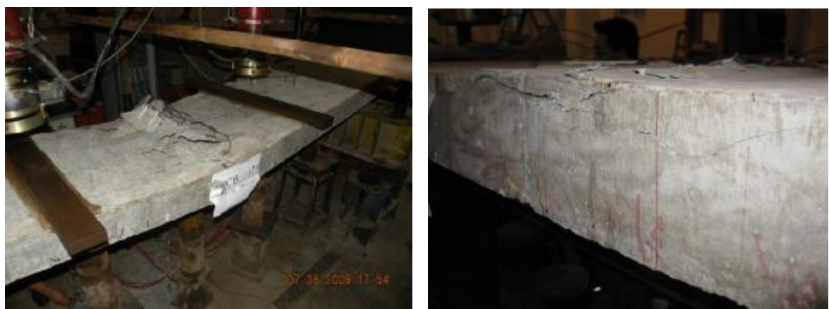
b. 跨中混凝土顶板混凝土压溃
