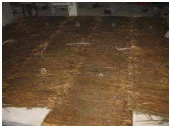
d. 混凝土翼板养护
