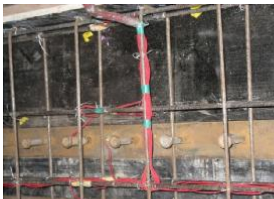
b. 钢梁、钢筋预贴应变片
