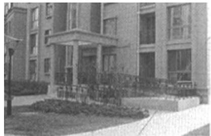
图 4-11 上海爱建园小区内住宅单元入口处的残疾人坡道
