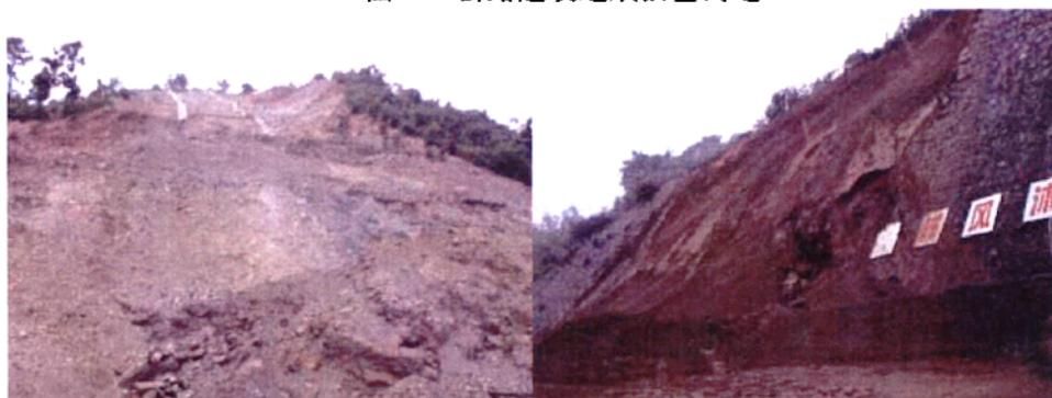
图 1.2 土壤侵蚀造成公路边坡失稳
