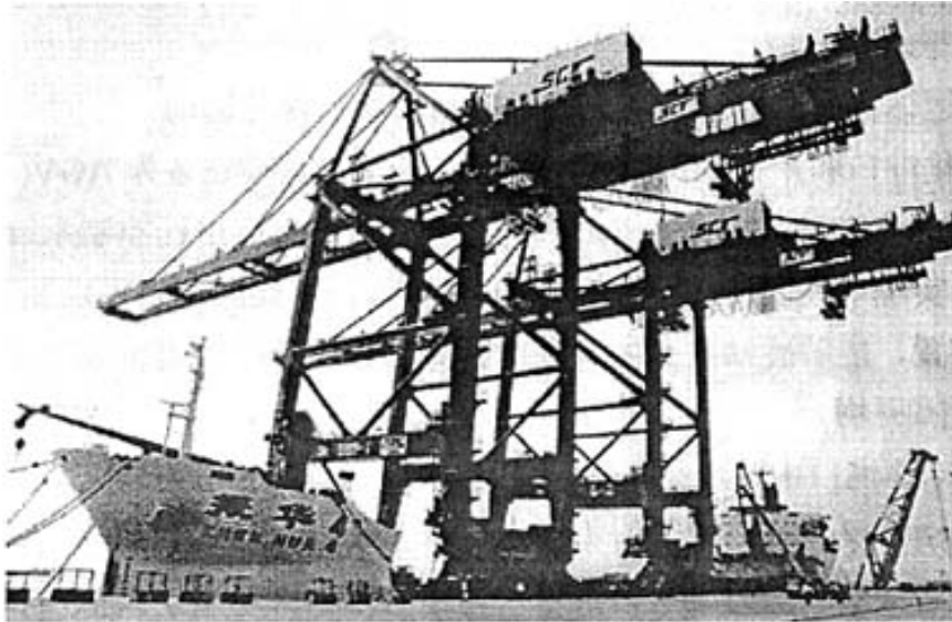
图 2.2 岸壁集装箱装卸桥实物图
