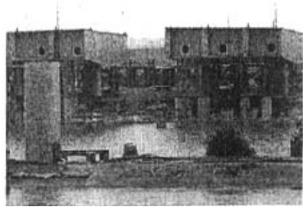
图 2-12 建造中的蕴藻浜大桥
