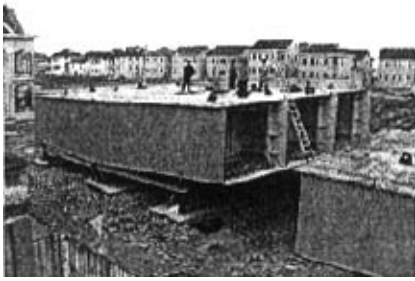
图 2-11 蕴藻浜大桥的钢结构箱型梁
