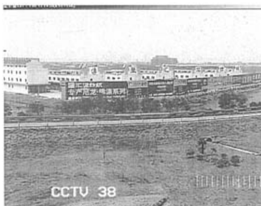
图 3-3-2 苏嘉杭高速公路右转匝道调查点
