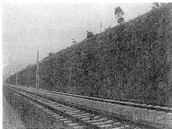
照片 2-6 鱼嘴车站喷射厚层基材植草护坡（摄于 2004.8）
