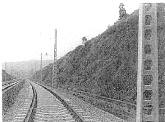
照片 2-5 鱼嘴车站喷射厚层基材植草护坡（摄于 2004.5）
