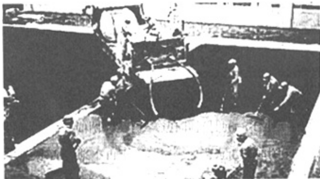
图6-2-1 洒铺水泥胶浆
