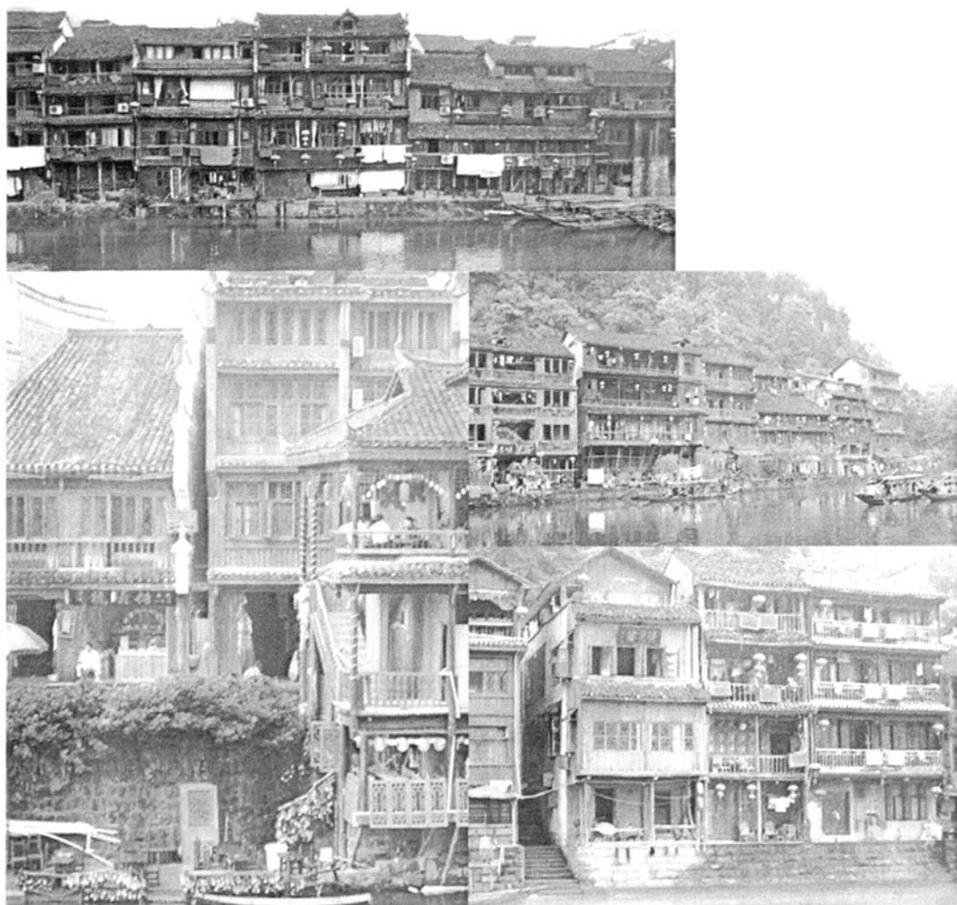
图 3—2 凤凰古城河岸吊脚楼现状二
