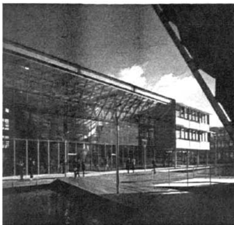
图 4-59 中心教学大厅
