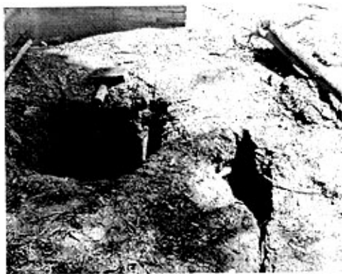
b 红薯窖反映左旋特征的剪切裂缝
