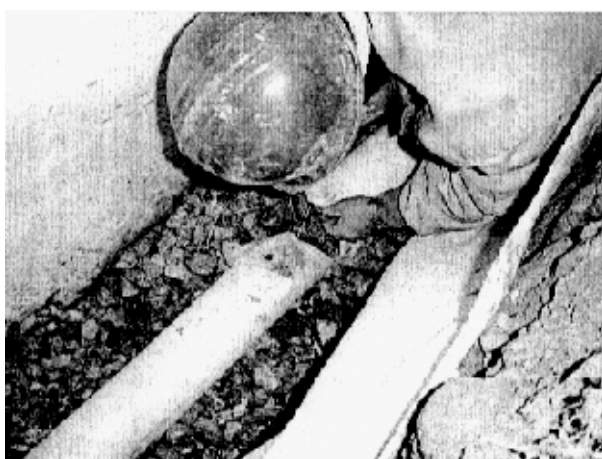
图 4.2.1-2 正在进行塑料盲沟的连接
