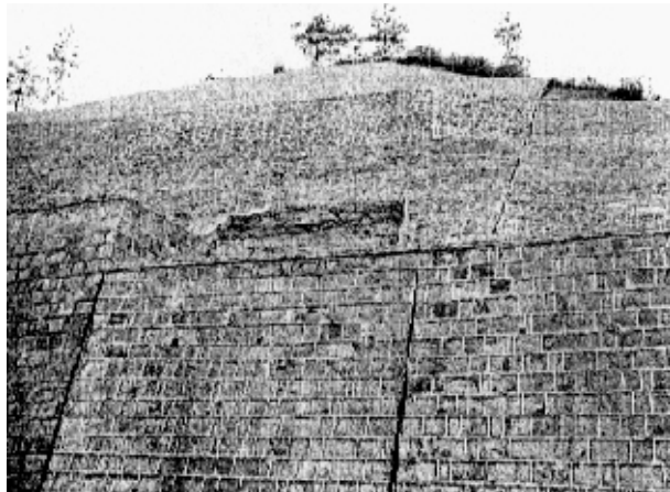
图 2.6.1-3 边坡塌落
