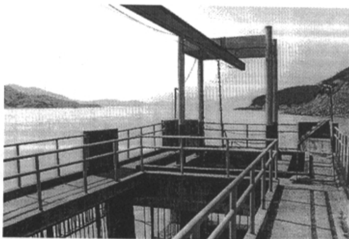
图 2-11 舟山海水腐蚀试验站实海腐蚀试验平台
