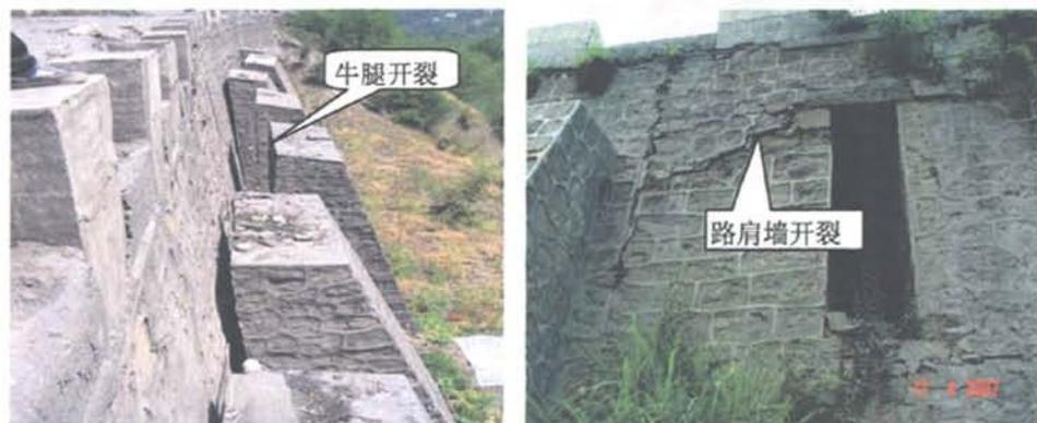
图 4.6 大红门滑坡引起的开裂现象
