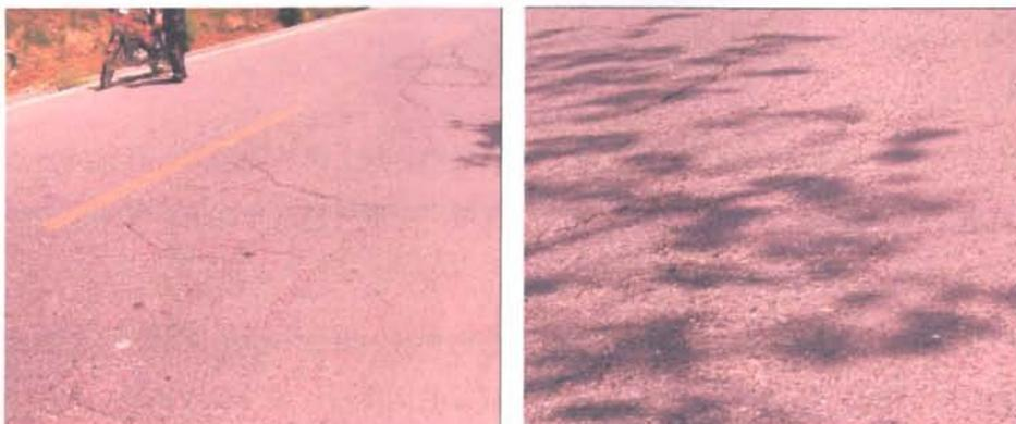
图 4.10 变形裂缝
