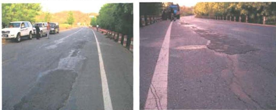
图 4.12 路基沉陷引起纵向裂缝
