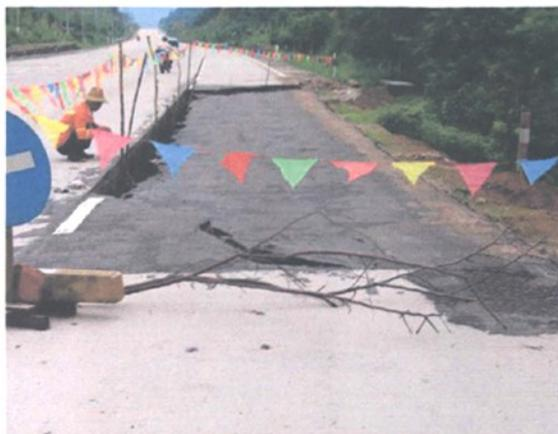
图 4.13 路基沉陷造成水泥板断裂
