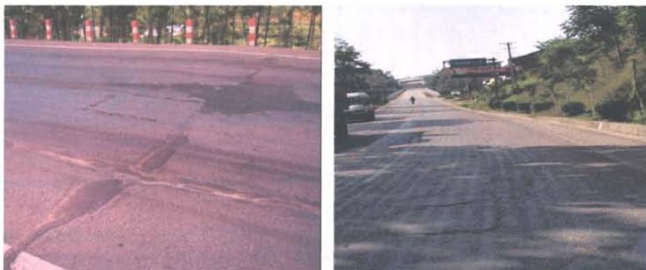
图 4.9 路基沉陷引起横向裂缝
