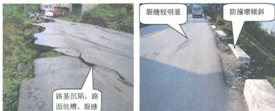
图 4.4 K1747+230 下边坡堆积层滑坡引起的破坏现象
