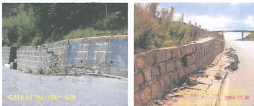
图 4.3 滑坡破坏的地面标志
