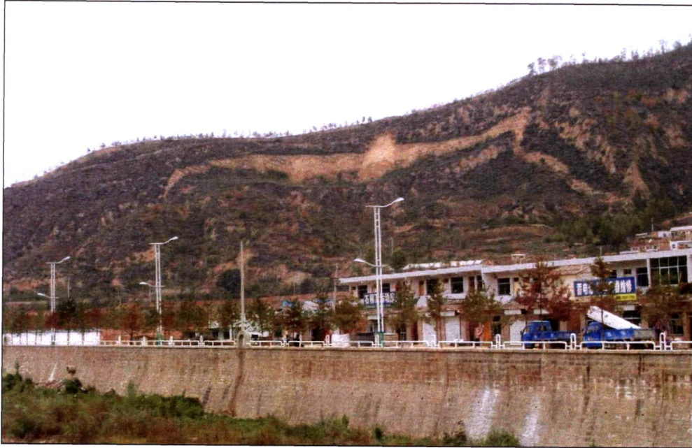
图 3.2 延安市虎头峁滑坡全貌
